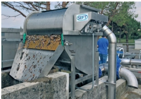
Рисунок 2. Сита для удаления крупных отходов
